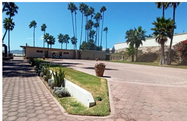
Figura 9. Vista hacia la edificación donde se pretende realizar la adecuación para la cava y los sanitarios.
