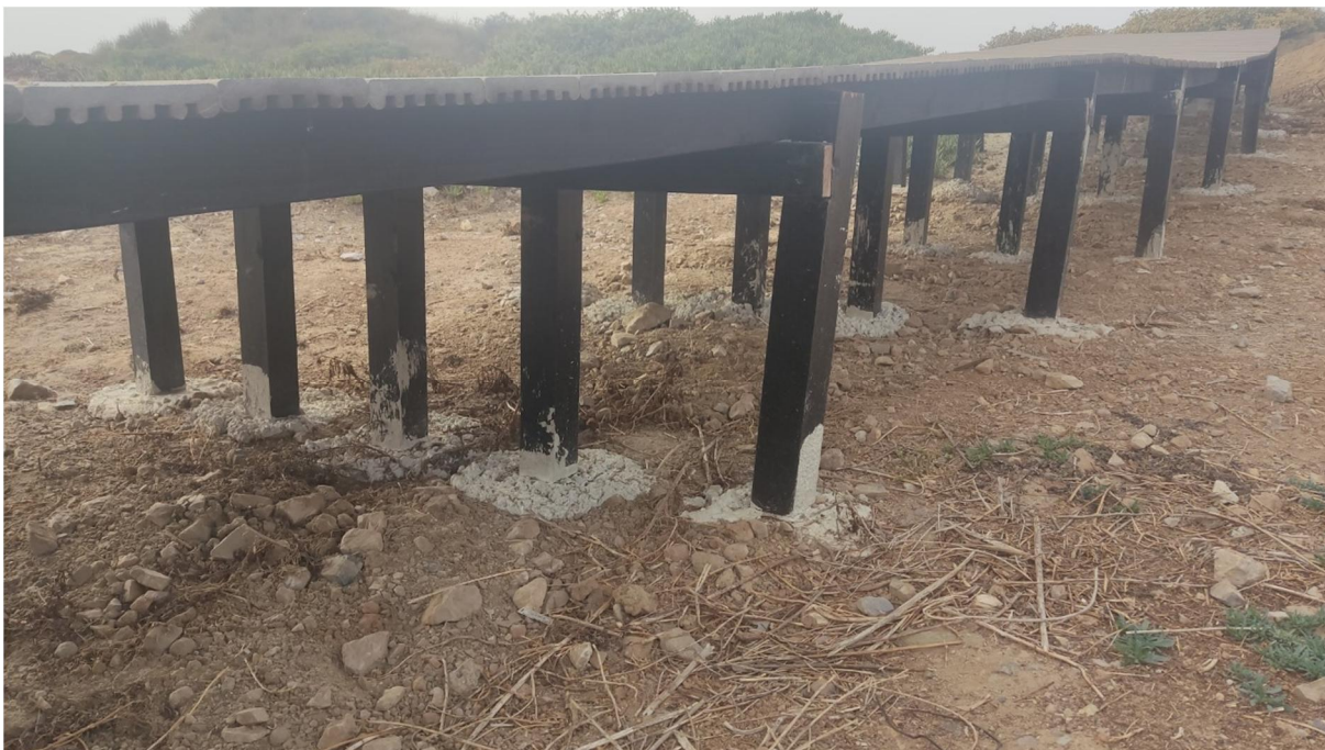
Foto 2. Hileras de 5 barrotes verticales ahogados en concreto y unidos por barrotes horizontales
