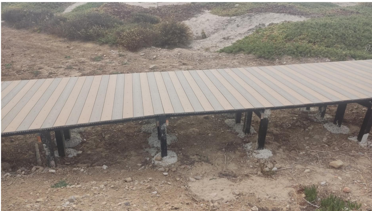
Foto 3. Tablas horizontales que forman el piso elevado del sendero
