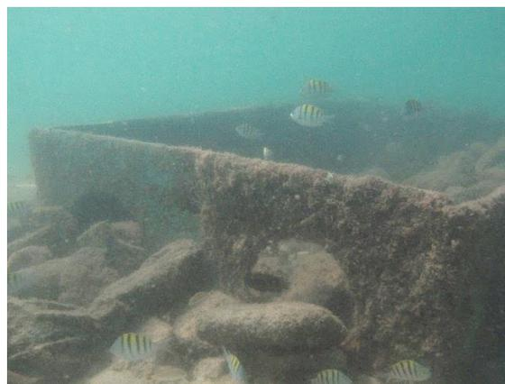
Gavión de fibra de vidrio rellena con piedra y grava, la cual es el punto de inserción de la tubería de extracción de agua, único tubo utilizado actualmente, se observa una gran cantidad de peces.
