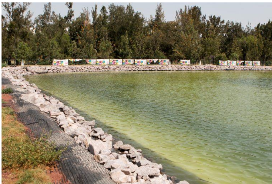
Ilustración Cap. II-4.- CONCEPTUAL ILUSTRATIVO EJEMPLO de un espejo de agua nadable, en este caso en la Magdalena Mixhuca en Ciudad de México, donde se observa el impermeabilizado con geotextil y la superficie de agua: fuente: www.agua.org.mx
