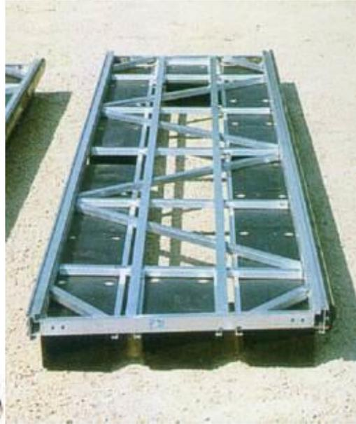
Figura 10. Estructura interna del muelle.
