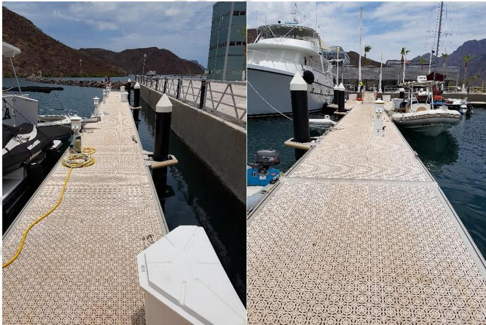
Figura 30. Muelles actuales en la marina “Escala Náutica Puerto Escondido” en buen estado después del paso del huracán Odile en 2014.
