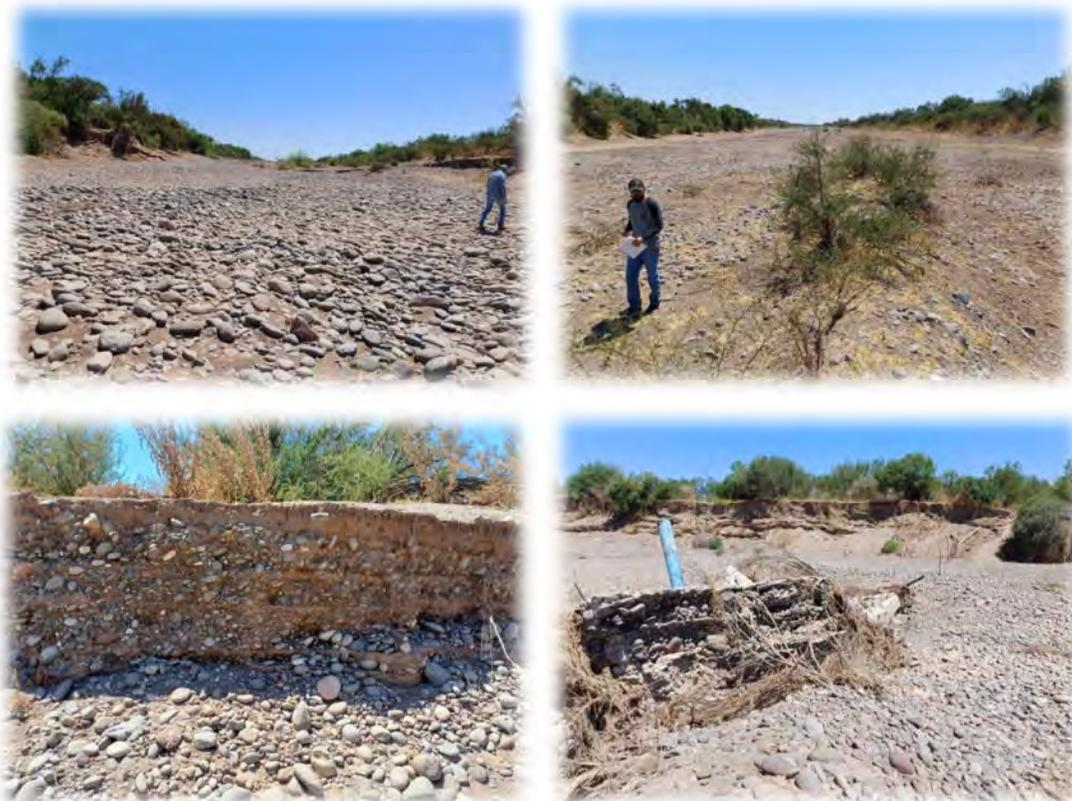
Figura II-26. Sección de cauce de arroyo para el bordo B5. Aguas abajo se encuentra un bordo destruido por avenidas extraordinarias y mal diseño; colinda con terrenos agrícolas y brechas de terracería.
