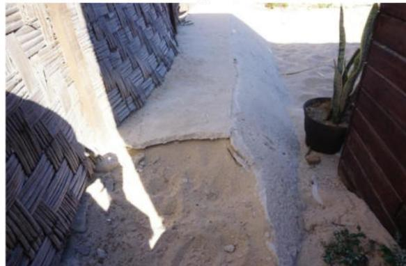
Plancha de cemento superficial para estabilizar el terreno
