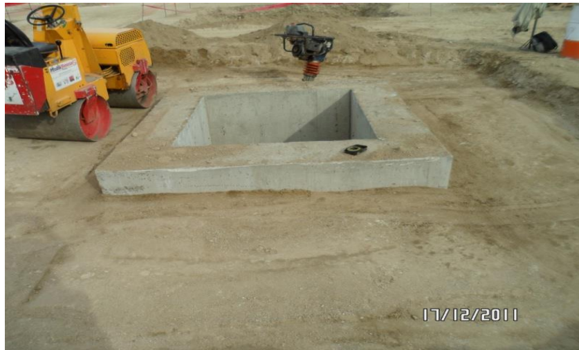
Figura 6. Idea gráfica de la compactación con rodillo liso y “Bailarina”
