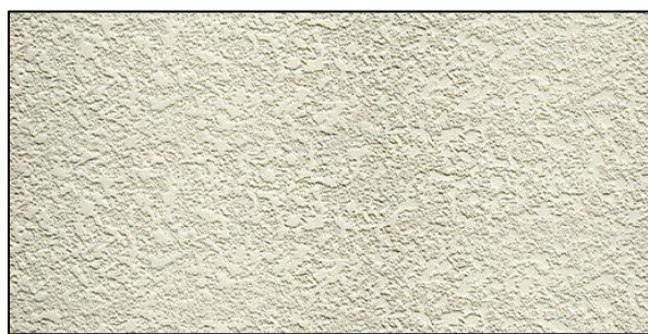
Figura 11. Apariencia de un tirol planchado en paredes y losas.
