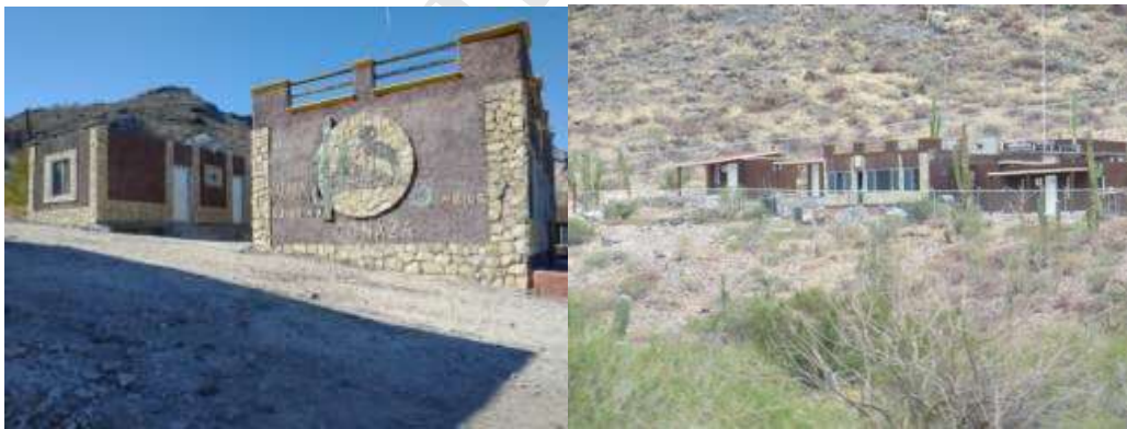
Figura 27. Instalaciones eco turísticas de la UMA LFA No. 1.
