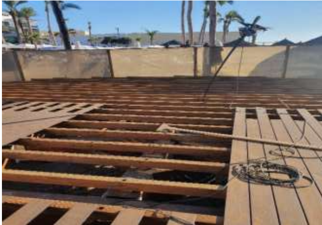
Estructura de madera flotada 50 cm sobre el nivel de arena.
