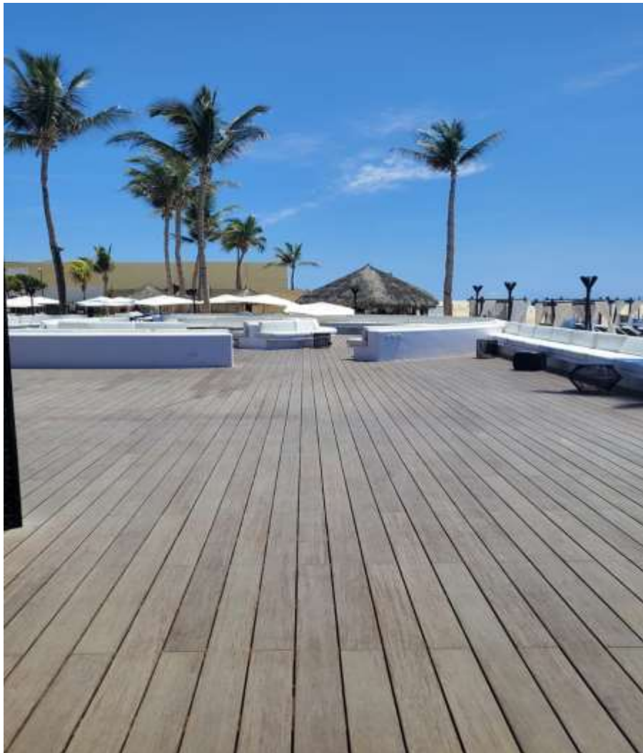
Área de terraza semi-fija de madera recubierta con conglomerado de bambú.
