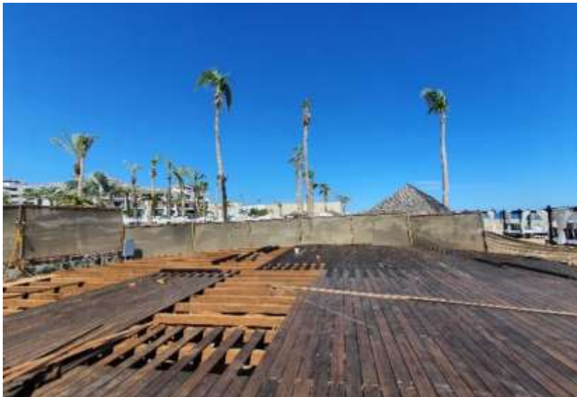
Estructura de madera para recibir duela de madera.
