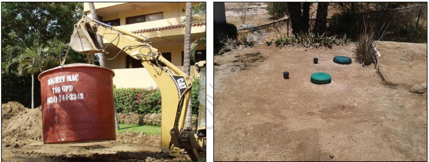
Figura 13. **Izquierda:** Fotografía que muestra el sistema de Plantas de Tratamiento de Aguas Residuales Aeróbicas de Mighty Mac que se instala bajo tierra. **Derecha:** Fotografía que muestra como luce el sistema una vez instalado, se observa que su impacto visual es bajo, ya que pasa fácilmente desapercibido.
