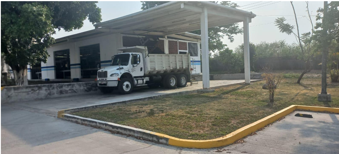
Foto 10.- Área de deshidratado de lodo: el biosólido deshidratado (antes lodos) es depositado en una tolva para ser llevado a terrenos agrícolas, en donde se aprovecha como mejorador de suelos y composteo.
