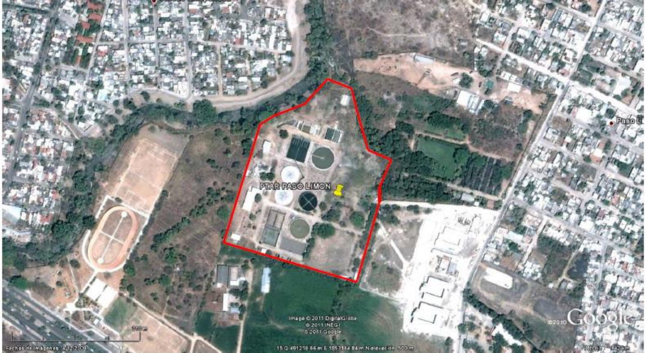
Aerofoto 1.- Ubicación de la PTAR Paso Limón, actualmente en operación.
