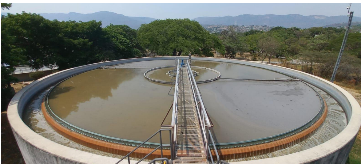
Foto 6.- Clarificador primario: permiten la separación de los sólidos sedimentables y el material flotante, durante esta etapa se lleva a cabo la remoción de la materia orgánica biodegradable cercana al 30%.
