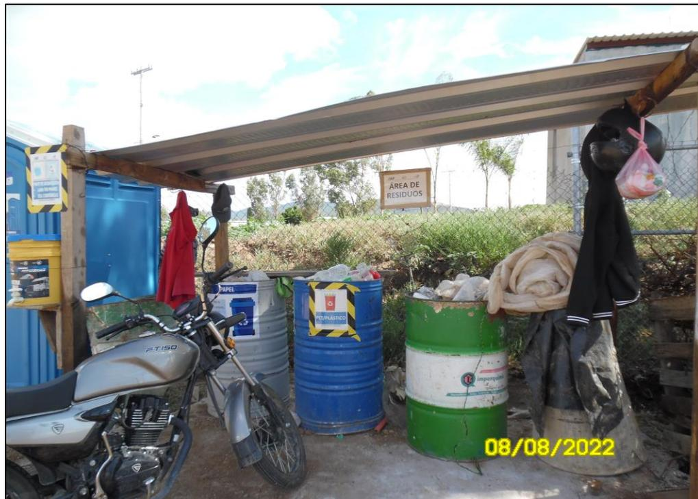
**Figura 6.5** Ejemplo del empleo de contenedores metálicos en obra para la disposición de residuos sólidos urbanos (TUAM, 2022).
