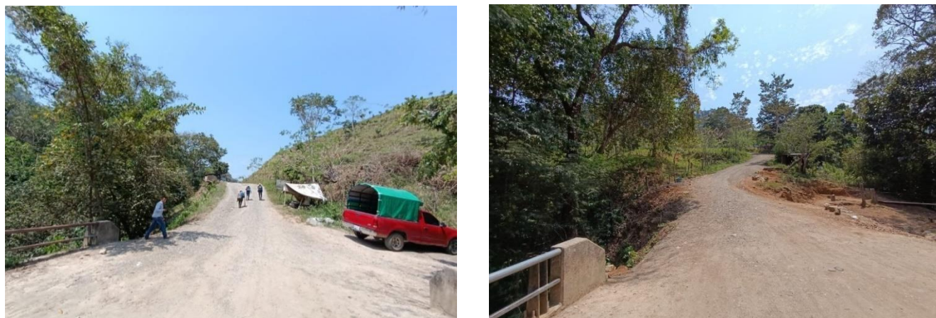
Figura II.4. Camino de terracería de acceso al proyecto.
