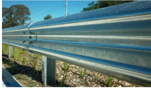
Figura II.8. Defensa metálica de dos crestas.
