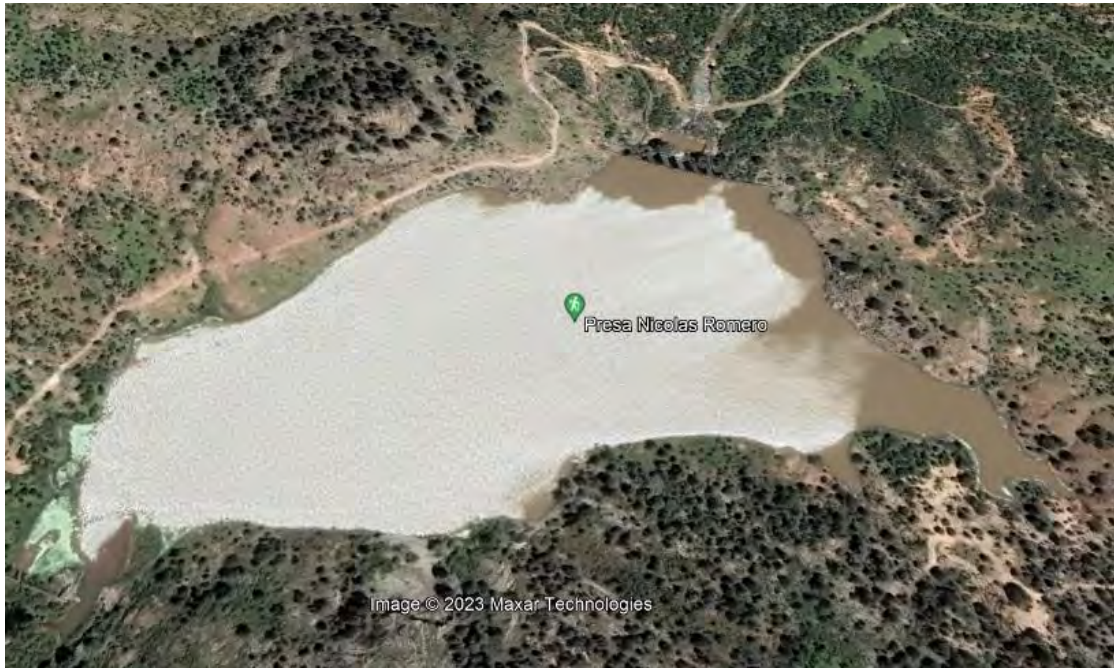
Ilustración II-9. Estado actual de la presa Nicolás Romero
