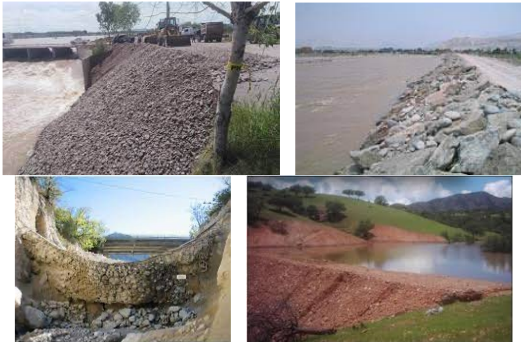
Figura 1.16. Imágenes descriptivas de las acciones de mantenimiento preventivo y correctivo a los bordos y taludes del arroyo intermitente Chihuahua.
