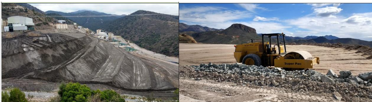
Figura II-29. Ejemplos de proyectos que manejan jales filtrados
