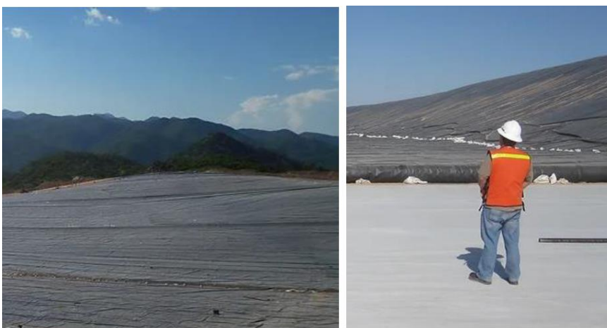
Figura III-33. Ejemplo de colocación de geomembrana
