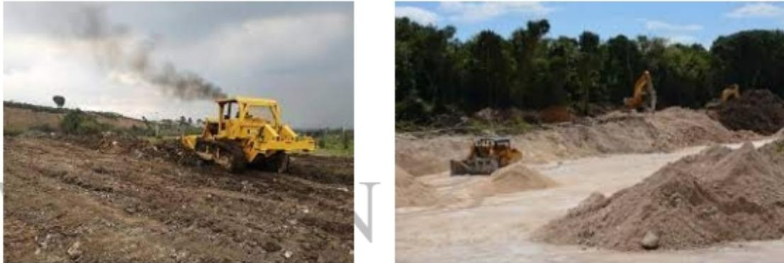
El movimiento de tierras del material vegetal se apoyará con un camión volteo y un cargador frontal y/o retroexcavadora como se muestran en la siguiente imagen.
