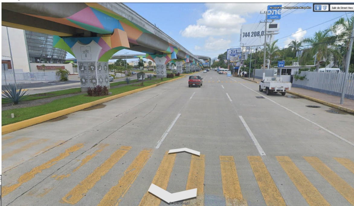
Fotografía frontal de la vialidad denominada Boulevard de las Naciones, la cual comunica los 365 días del año el área del proyecto con el Aeropuerto y la zona urbanizada del Municipio de Acapulco.
