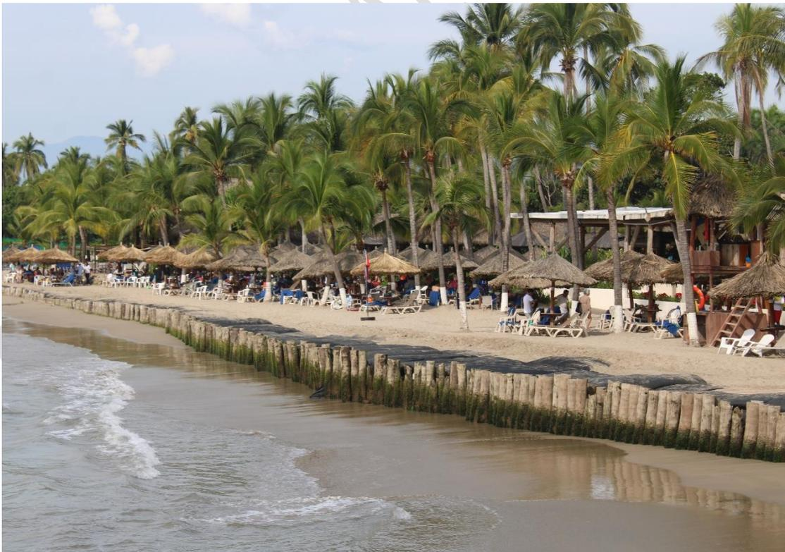
*Fotografía terrestre frontal, donde se puede apreciar los troncos existentes de madera, en condiciones con desgaste.*
