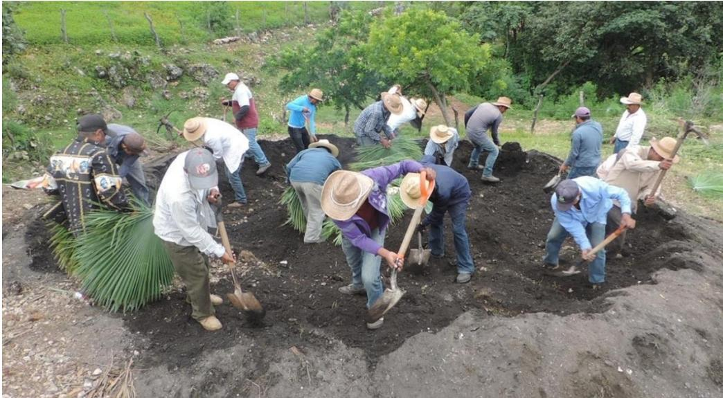
Figura 26. Tapado del horno.
