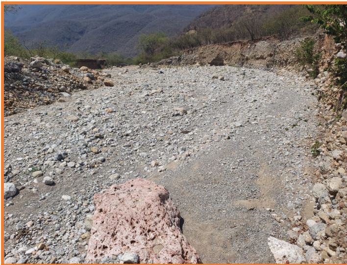
Foto 3. Vista del centro del banco de material.
