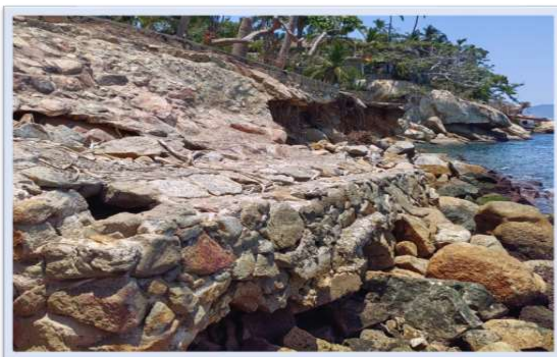
Ilustración 8. Grieta de la valla perimetral, provocado por deslave.
