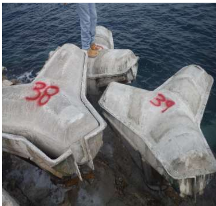
Ilustración 9. Tetrápodos, a utilizar, como disipadores de energía.
