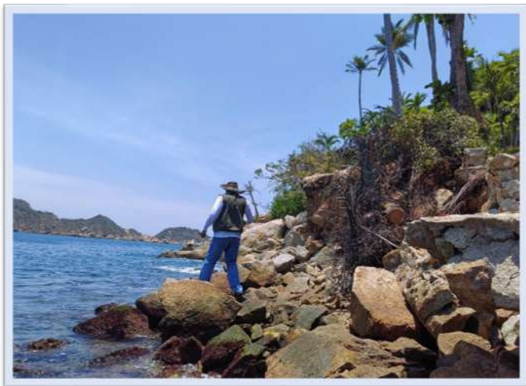
Ilustración 3. Desechos del Área de la compuerta destruida.
