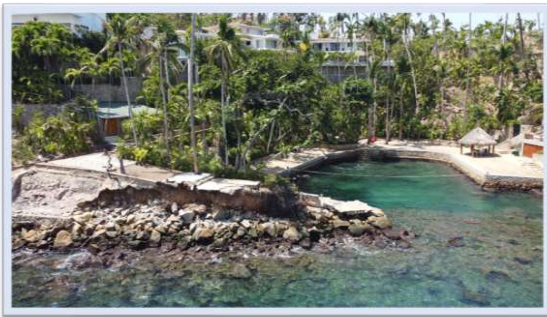
Ilustración 1. Zona del proyecto, en la que se observa las afectaciones, a causa del fenómeno OTIS.
