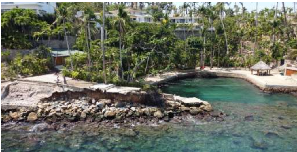
Ilustración 1. Condición actual del sitio del proyecto.
