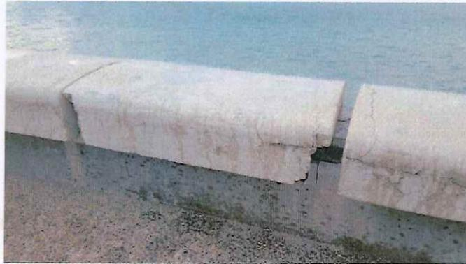
*Ilustración 13. Piezas de concreto fluido en rampas dañadas*
