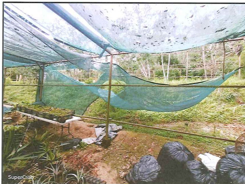
Daños causados por el paso del Huracán Lidia categoría 4, (10 de octubre del 2023)
