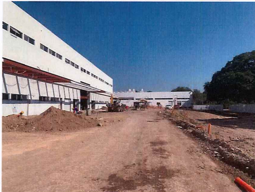
IMAGEN I. 24- EDIFICIO DE SERVICIOS
