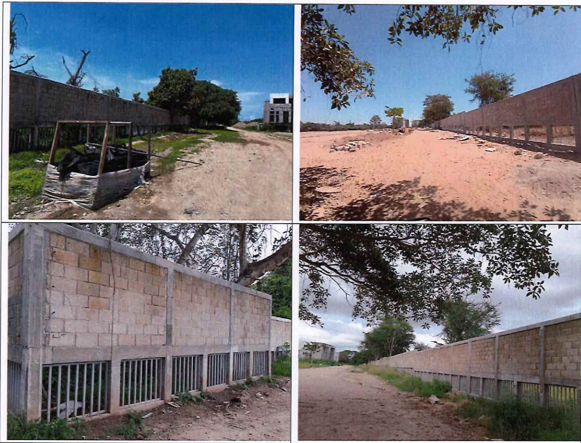
IMAGEN I. 32- ESTRUCTURA LÍMITROFE CON PASOS PLUVIALES MURO DE BLOCK
