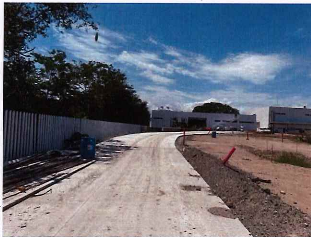
IMAGEN I. 33- CERCA PERIMETRAL TUBULAR PERMITE EL ESCURRIMIENTO PLUVIAL
