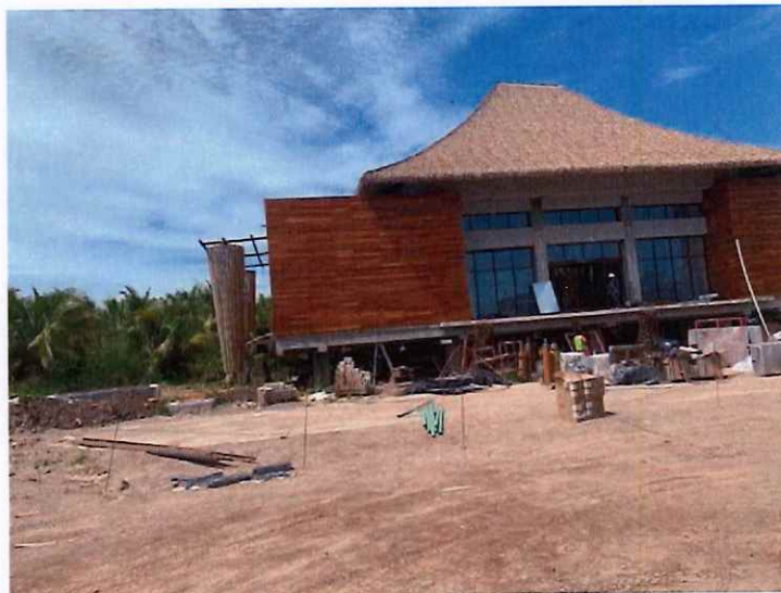
IMAGEN I. 14- OBRA LIMPIA Y LIBRE DE RESIDUOS.
