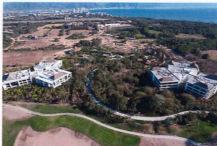
IMAGEN I. 31- AVANCE GENERAL DE OBRA
