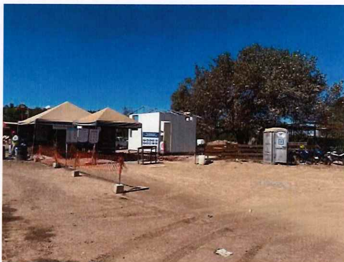
IMAGEN I. 27- ÁREAS DESTINADAS PARA LA DISPOSICIÓN DE MATERIALES, DE MANERA ORDENADA Y SEPARADA.
