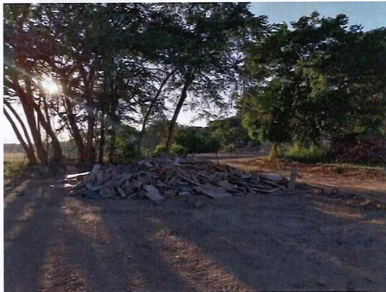
IMAGEN I. 17- SEPARACIÓN PARA RE VALORIZACIÓN DE RESIDUOS DE LA CONSTRUCCIÓN (MADERA).
