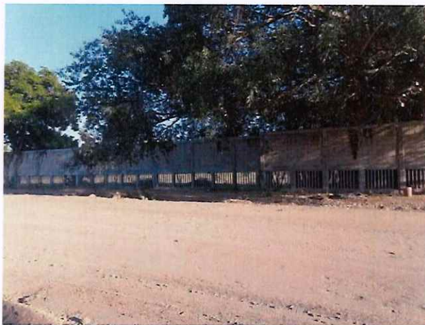
IMAGEN I. 32- BARDAS PERIMETRAL CON PASOS PLUVIALES
