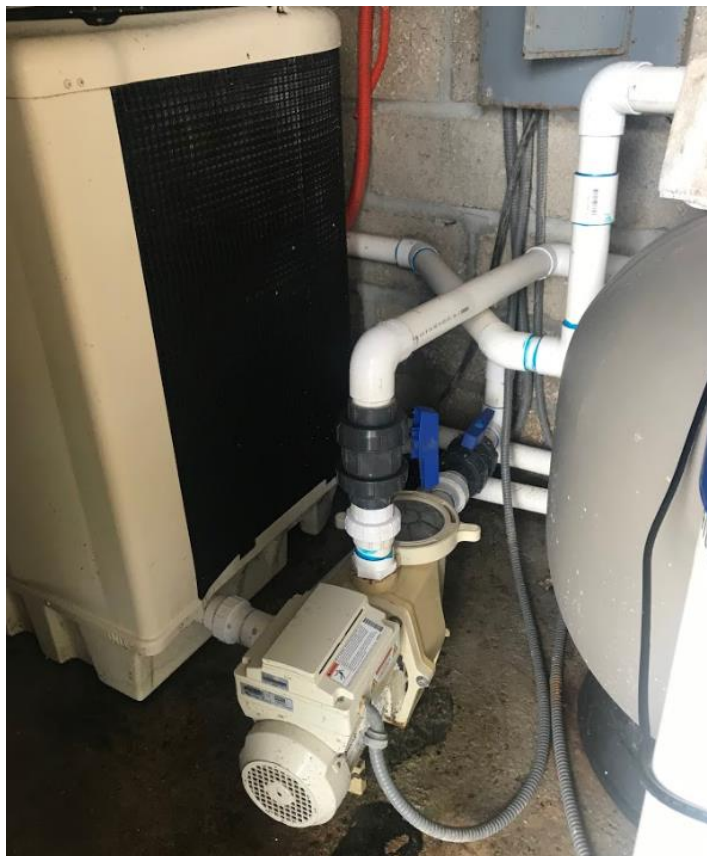
Figura II. 2 Sistema de bombeo para alberca y jacuzzi
