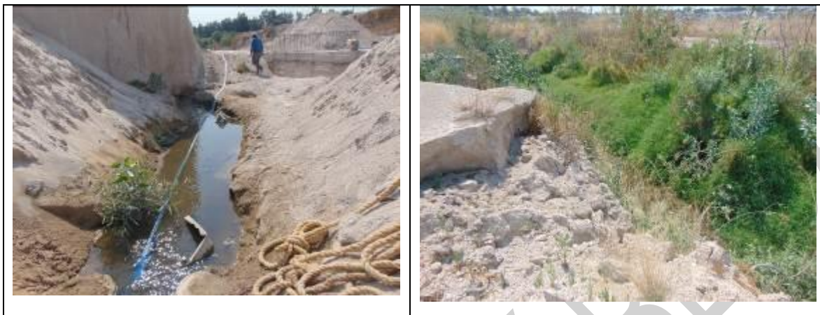
Figura II-11. Condiciones actuales de la zona de trabajo
