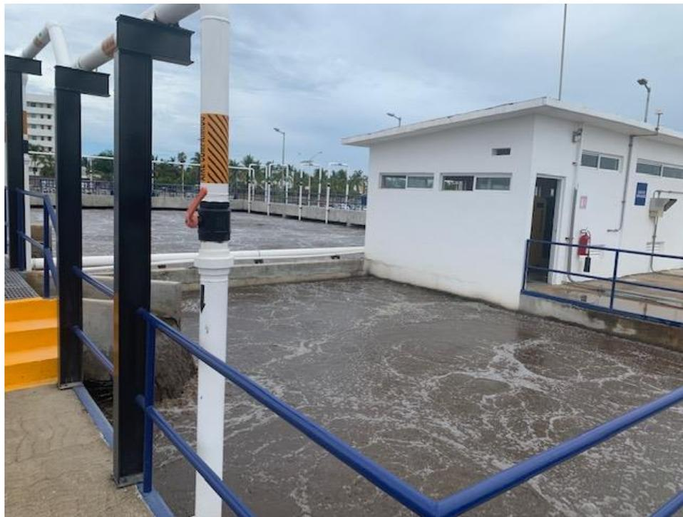
ILUSTRACIÓN 10- SISTEMA DE LODOS ACTIVADOS EN AIREACIÓN EXTENDIDA, PTAR NAYARIT.
