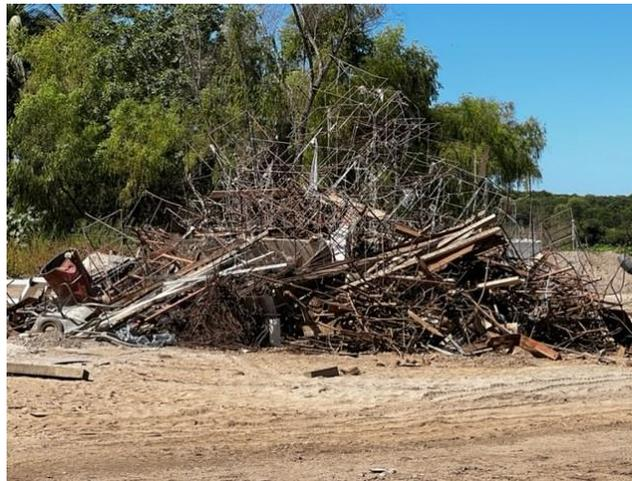
IMAGEN I. 3- SEPARACIÓN PARA RE VALORIZACIÓN DE RESIDUOS DE LA CONSTRUCCIÓN (VARILLAS).
