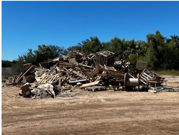
IMAGEN I. 4- SEPARACIÓN PARA RE VALORIZACIÓN DE RESIDUOS DE LA CONSTRUCCIÓN (MADERA).
