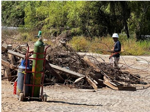
IMAGEN I. 5- SEPARACIÓN PARA RE VALORIZACIÓN DE RESIDUOS DE LA CONSTRUCCIÓN (METALES).
