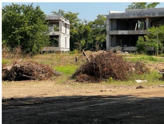
IMAGEN I. 60- ÁREAS DESTINADAS PARA LA DISPOSICIÓN DE MATERIALES, DE MANERA ORDENADA Y SEPARADA.
