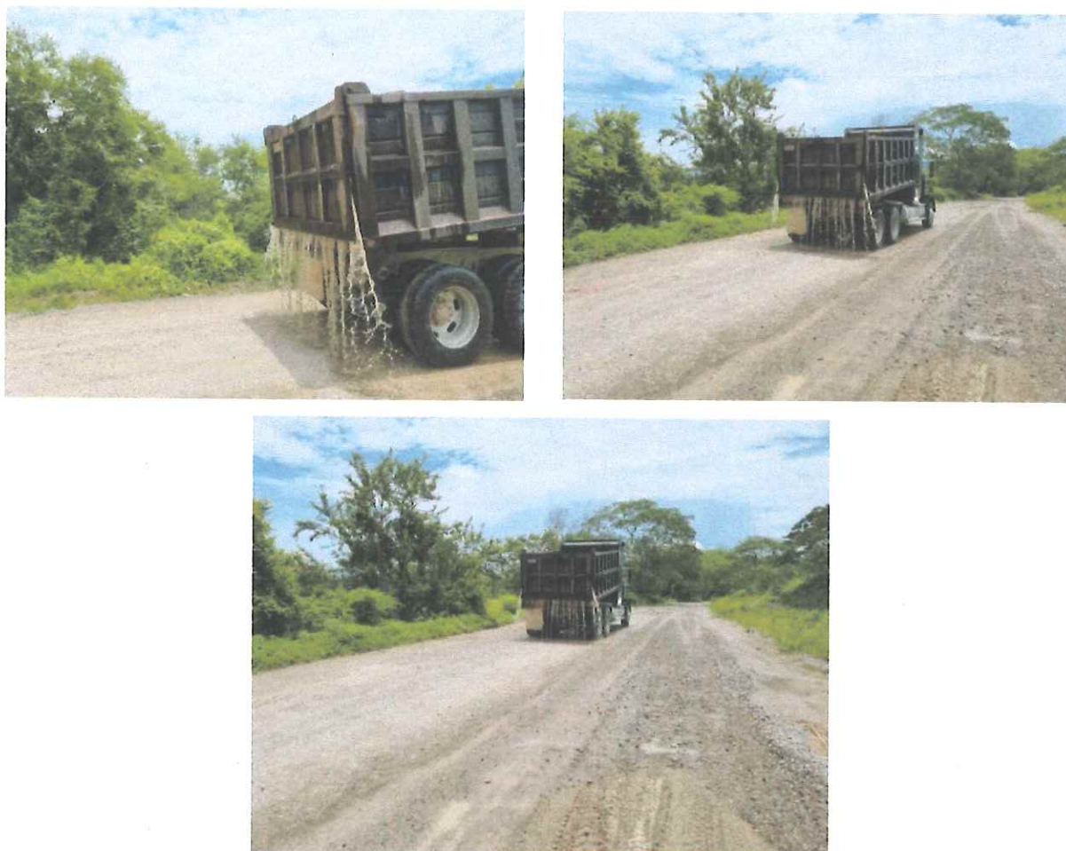
Imagen 3. Acciones de riego del acceso rústico.
