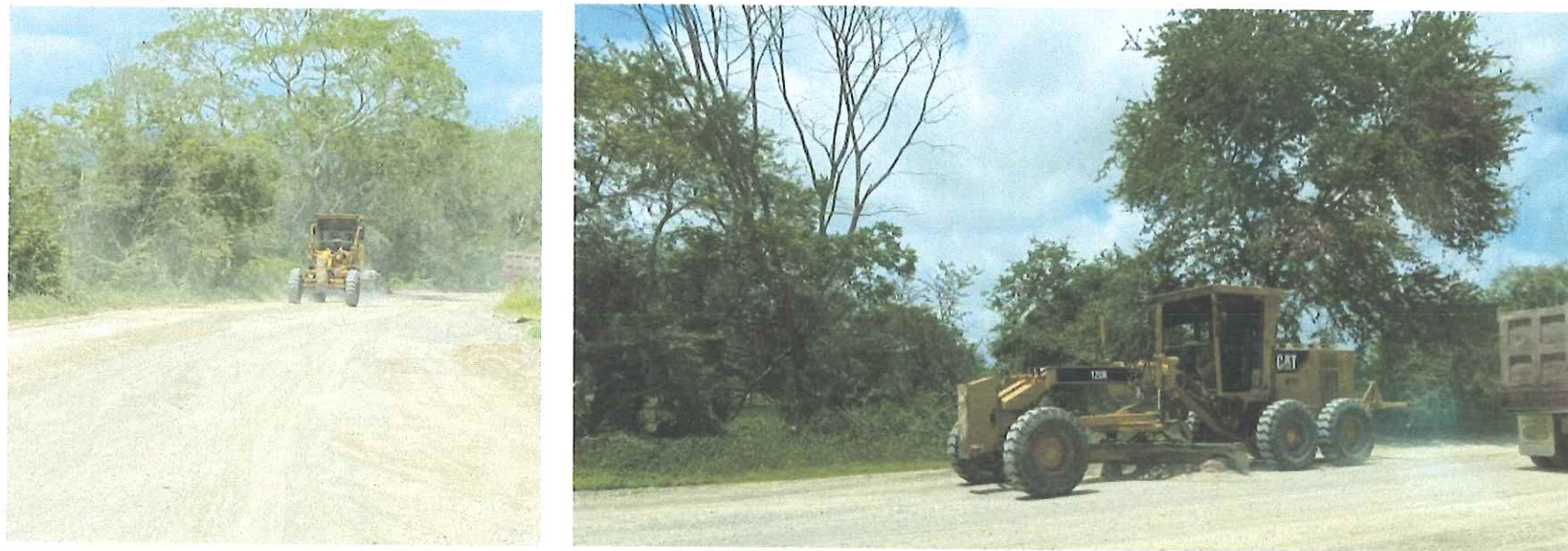
Imagen 4. Acciones de nivelación del camino rústico correspondientes al año 2018.
