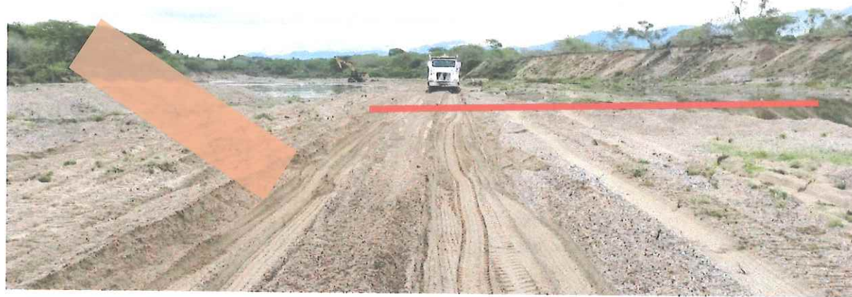
Imagen 9. Área de amortiguamiento mayor a 15 metros entre la sección hidráulica y el sitio de extracción
