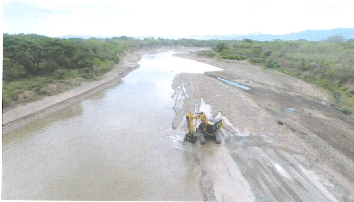
Imagen 8. Acción de hincado de cucharón para extracción de material
