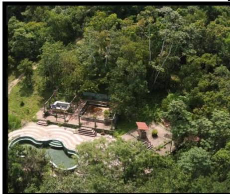
Fig. 3. Estado actual del sitio del Proyecto
