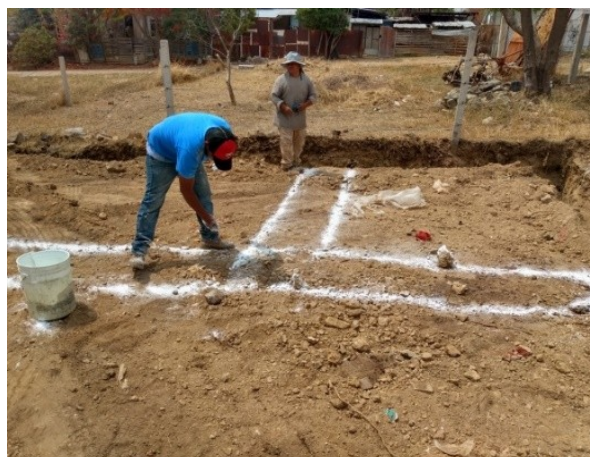
Imagen II.6. Ejemplo de trazo y marca del área para el inicio de la construcción.
