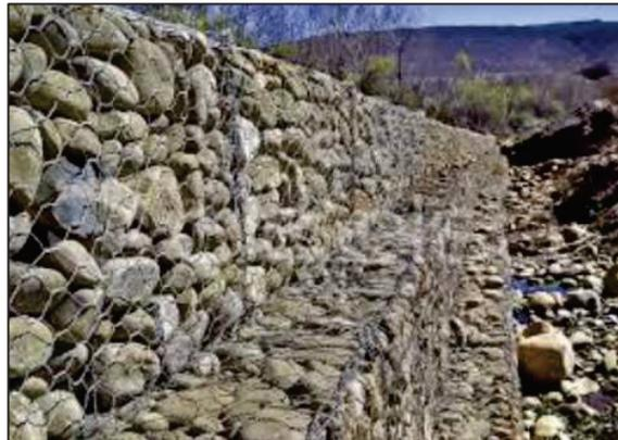
Figura II.11.- Ejemplo del sistema de gaviones a instalar en los sitios de las obras de descarga No. 1 y No. 3.
