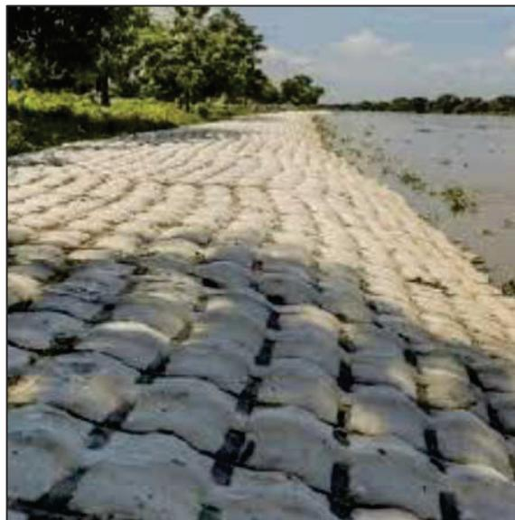
Figura II.12.- Ejemplo del sistema de membrana Colchacreto.
