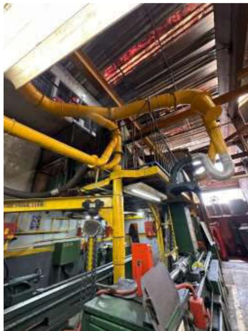
Figura 53. Colector de polvos del área de pulido.
