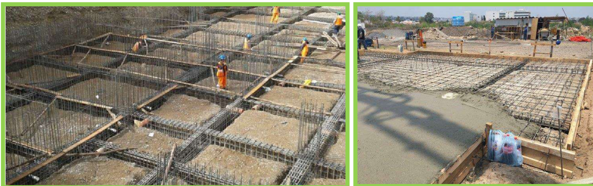
Imagen II.15 Cerrado de cimentación
