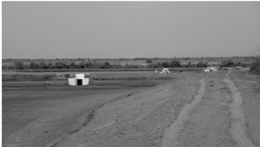
Compuerta de salida del estanque uno al estanque dos, construida sobre el bordo divisor de los estanques.
