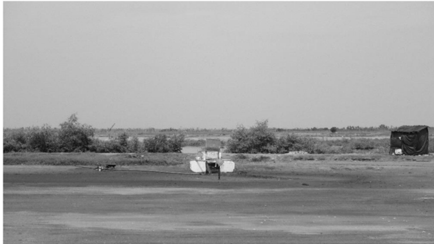
Compuerta de salida del estanque dos que descarga al dren de descarga, al fondo terrenos de Marismas.
