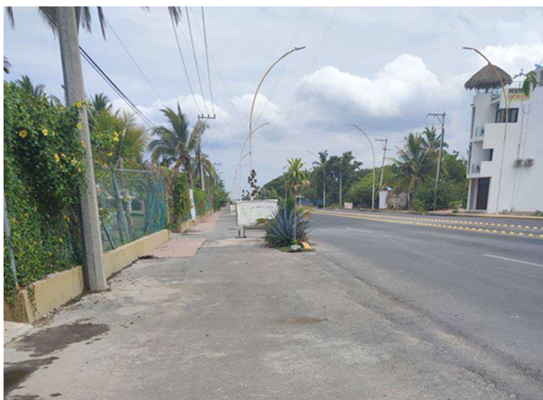
Imagen que muestra el Boulevard Matanchén mismo que está asfaltado
