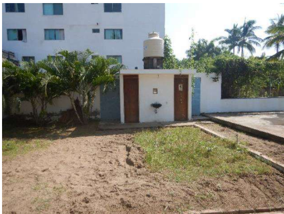
Figura 7. Vista hacia interior, baños.
