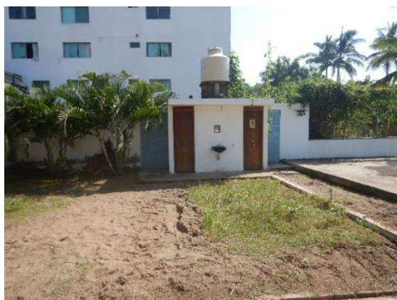
Figura 9. Vista hacia interior, baños.
