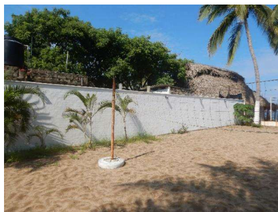
Figura 10 Vista hacia interior, muros de concreto.
