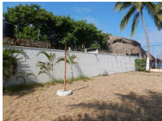
Figura 15 Vista hacia interior, muros de concreto.
