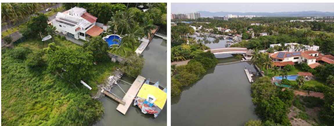
FIGURA III. 8 VISTAS AÉREAS DEL LOTE COLINDANTE Y EL CANAL DE NAVEGACIÓN DEL PROYECTO
