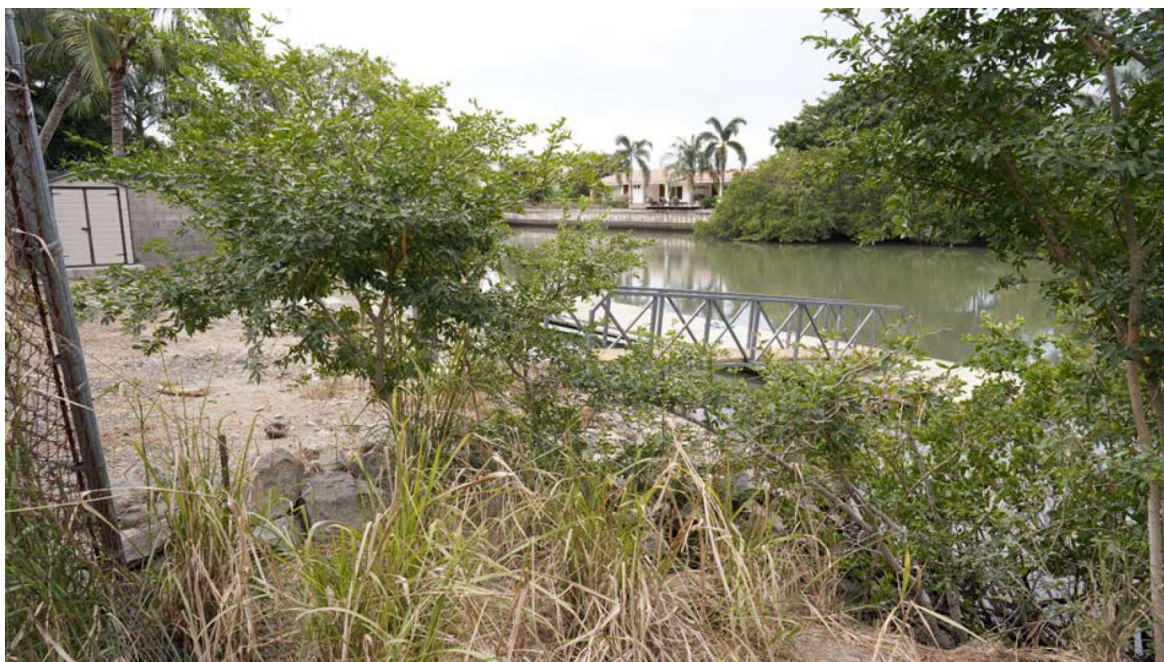
FIGURA II. 4 MUELLE EXISTENTE EN EL LOTE COLINDANTE AL SUR DEL PROYECTO
