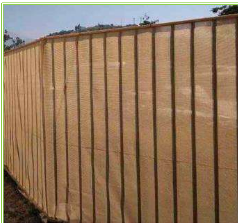
Imagen VI.1 Tipo de valla a instalar con troncos de madera y malla sombra
