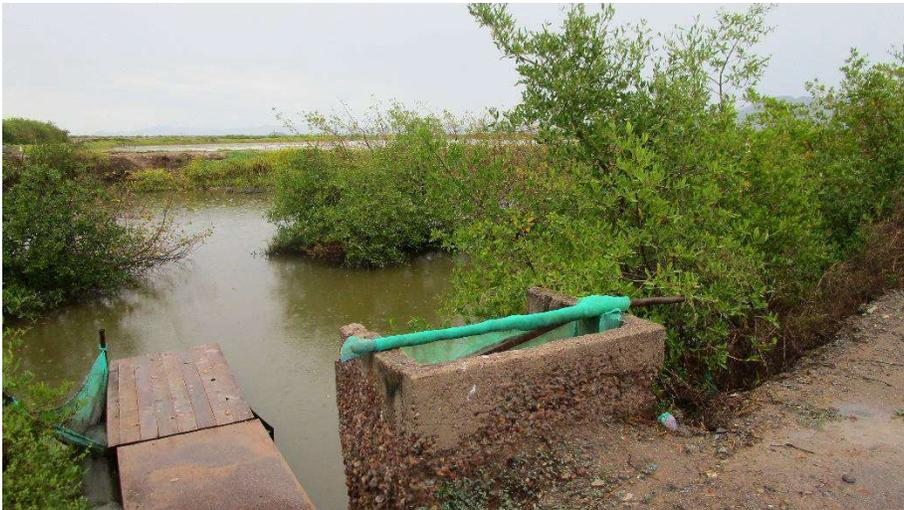
Compuerta de salida al norte del estanque que descarga al dren de descarga, se observa vegetación de mangle y halófila sobre el talud, en caso de observarse disminución de vegetación halófila en el sitio, se prevé el establecimiento inducido con mangle para estabilizar y conservación del talud del dren y aporte al hábitat de especies silvestres. Al fondo terrenos de la Granja acuícola La Urraquita.
