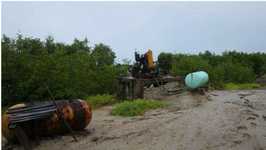
Se aprecia al fondo el cárcamo de bombeo, se observan un deposito estacionario de diésel que alimenta al motor sobre una base de concreto y block.
