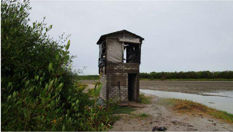
Caseta de vigilancia (construida a base de block, varilla, cemento, concreto y piso de tierra), ubicada en la bordería de la granja.
