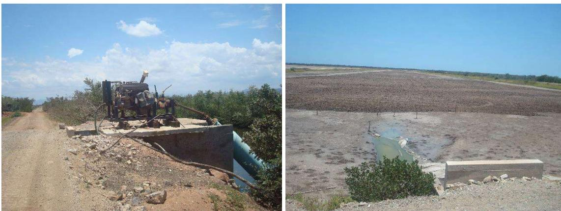
En la imagen izquierda se aprecia el cárcamo de bombeo sobre el bordo del canal de llamada existente, a la derecha se aprecia la compuerta de alimentación que alimenta de agua a la granja que a través de su estanque transporta el agua que permite abastecer a los estanques de la granja.
