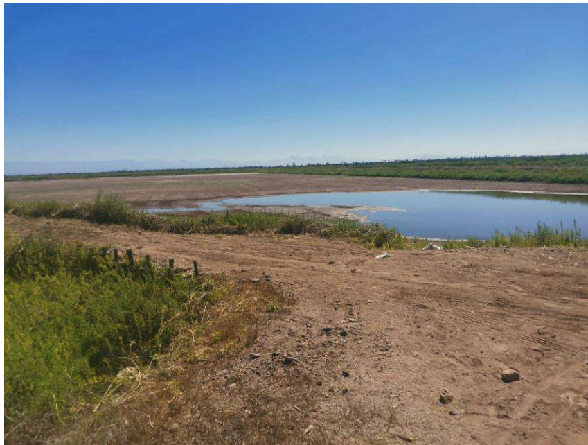
Vista Panorámica de la granja, se aprecia parcialmente el estanque 3 y bordería.
