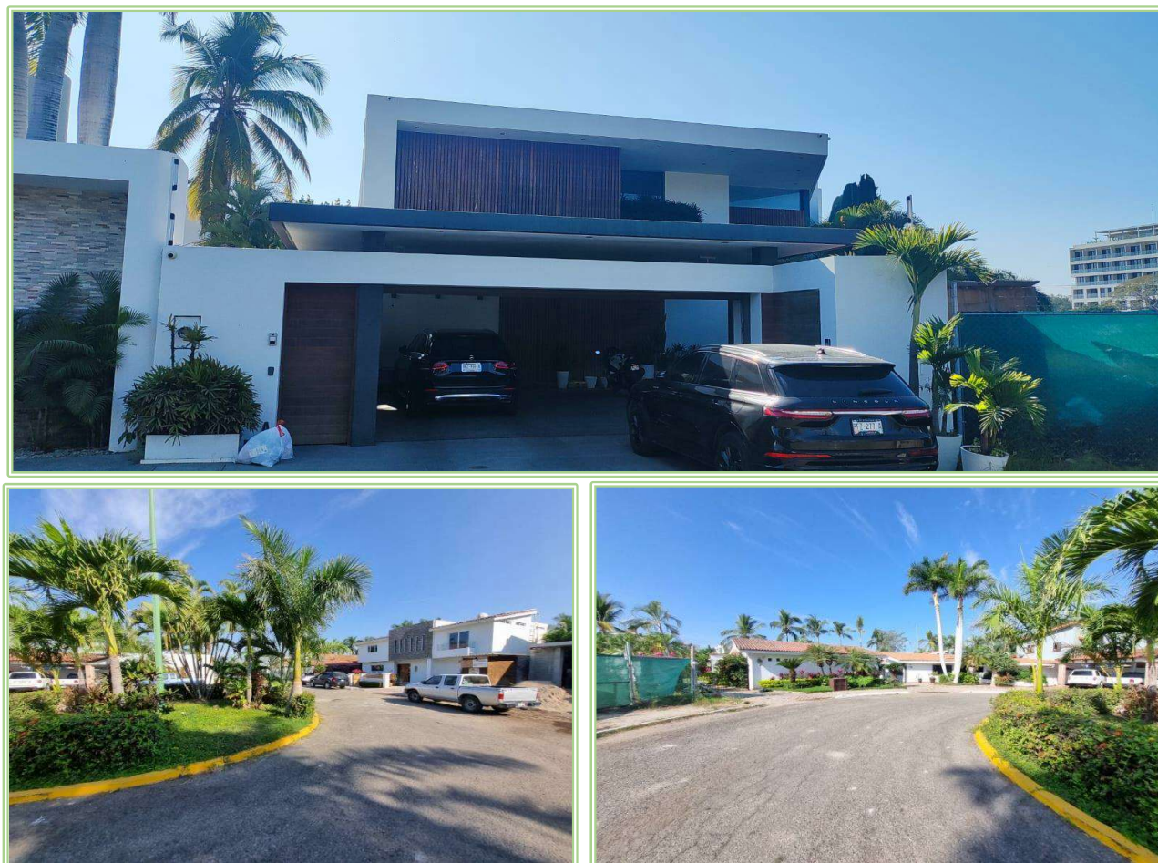
Imagen IV.2 Colindancia del predio que muestra la calle de acceso al predio calle tulipanes y casas colindantes
