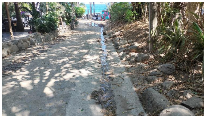
Vista de la infraestructura pluvial (cuneta) ubicada sobre la Calle Islas Marías para la conducción superficial de los escurrimientos pluviales
