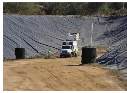
Nueva celda con geomembrana para la disposición final de los residuos
