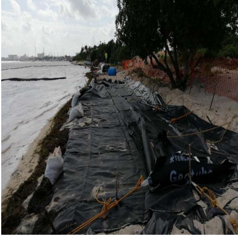
Ejemplo de Tapete antisocavación apoyado de estacas y varillas.
