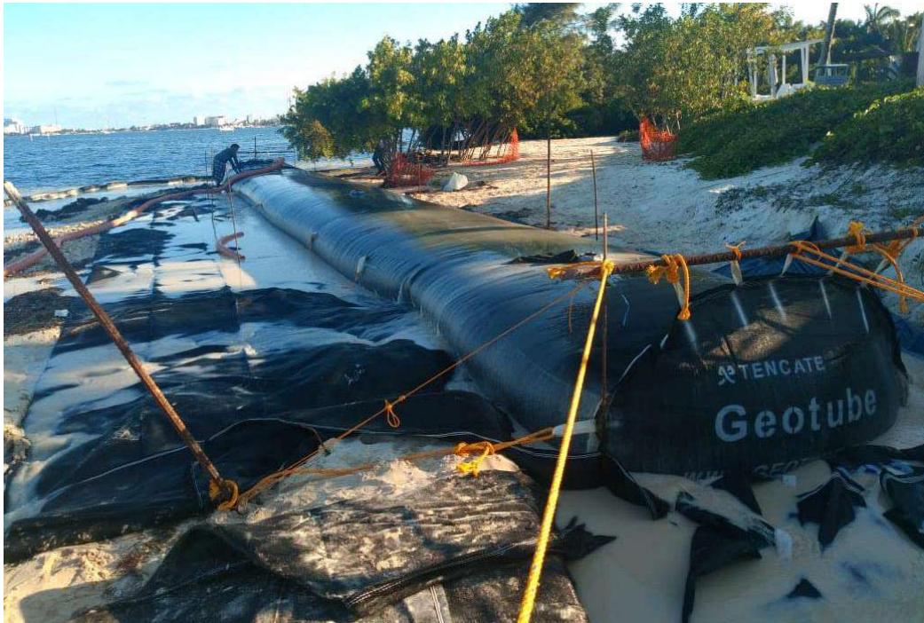
Ejemplo de Geotubo en proceso de llenado
