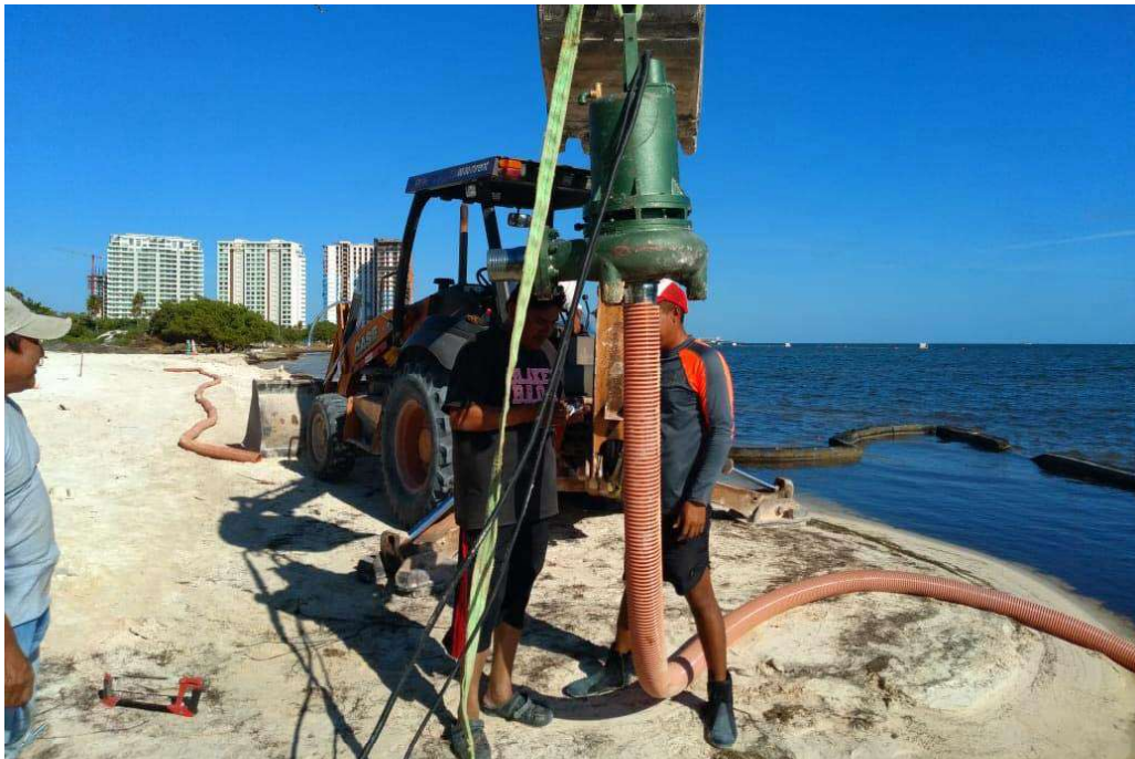
Ejemplo de Maquinaria sosteniendo bomba tragasólidos conectado a una tubería flexible de 6 pulgadas.
