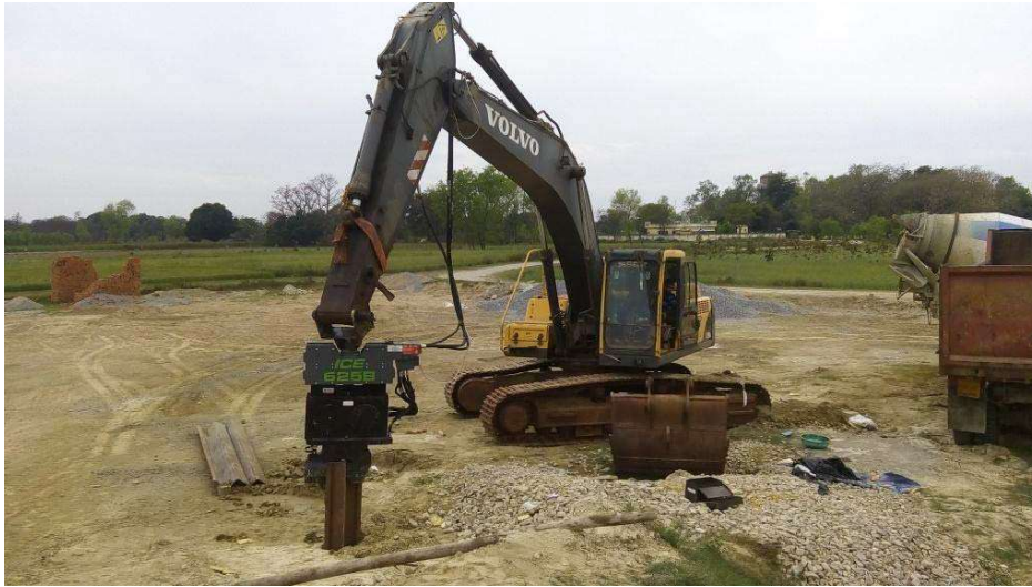
Excavadora equipada con un vibrohincador
