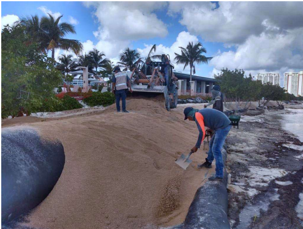
Retroexcavadora y personal relleno y cubriendo los geotubos con arena.
