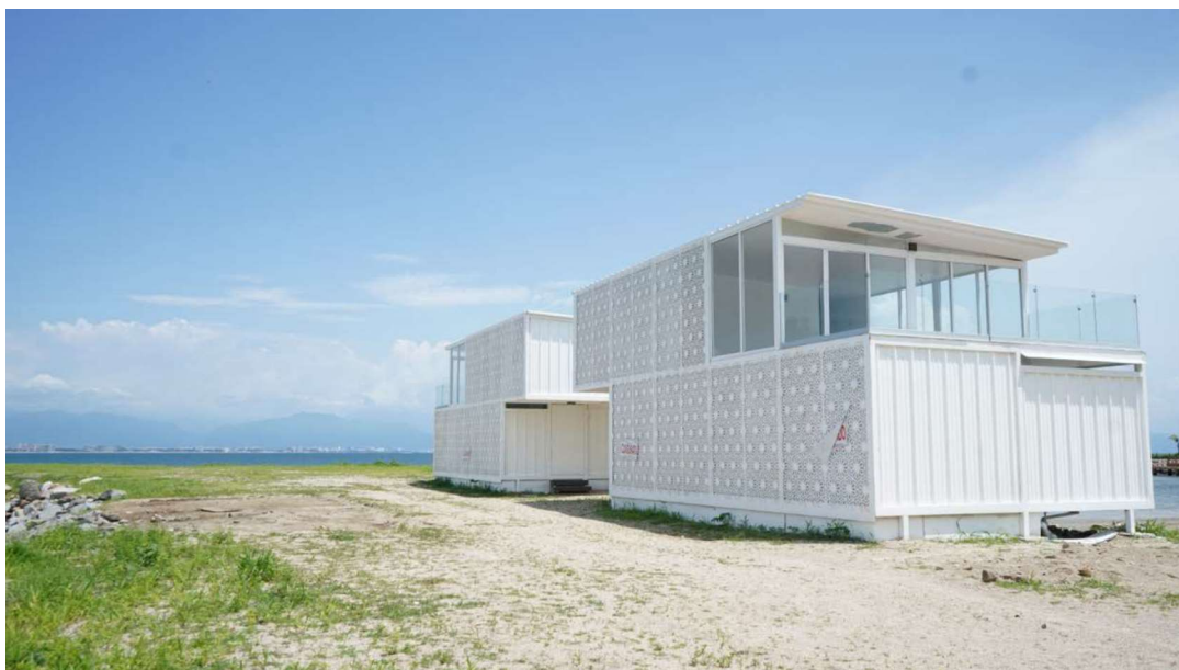
FIGURA II. 1 CONSTRUCCIONES EXISTENTES MODULOS DE BAÑOS DE HOMBRES Y MUJERES
