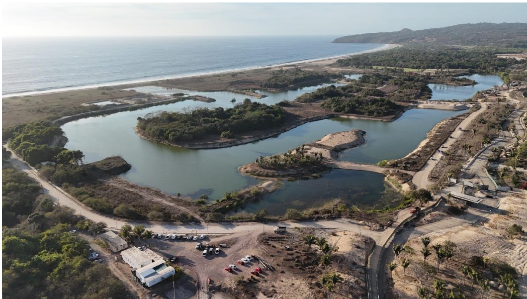
Vista de la Marina parcialmente construida.
