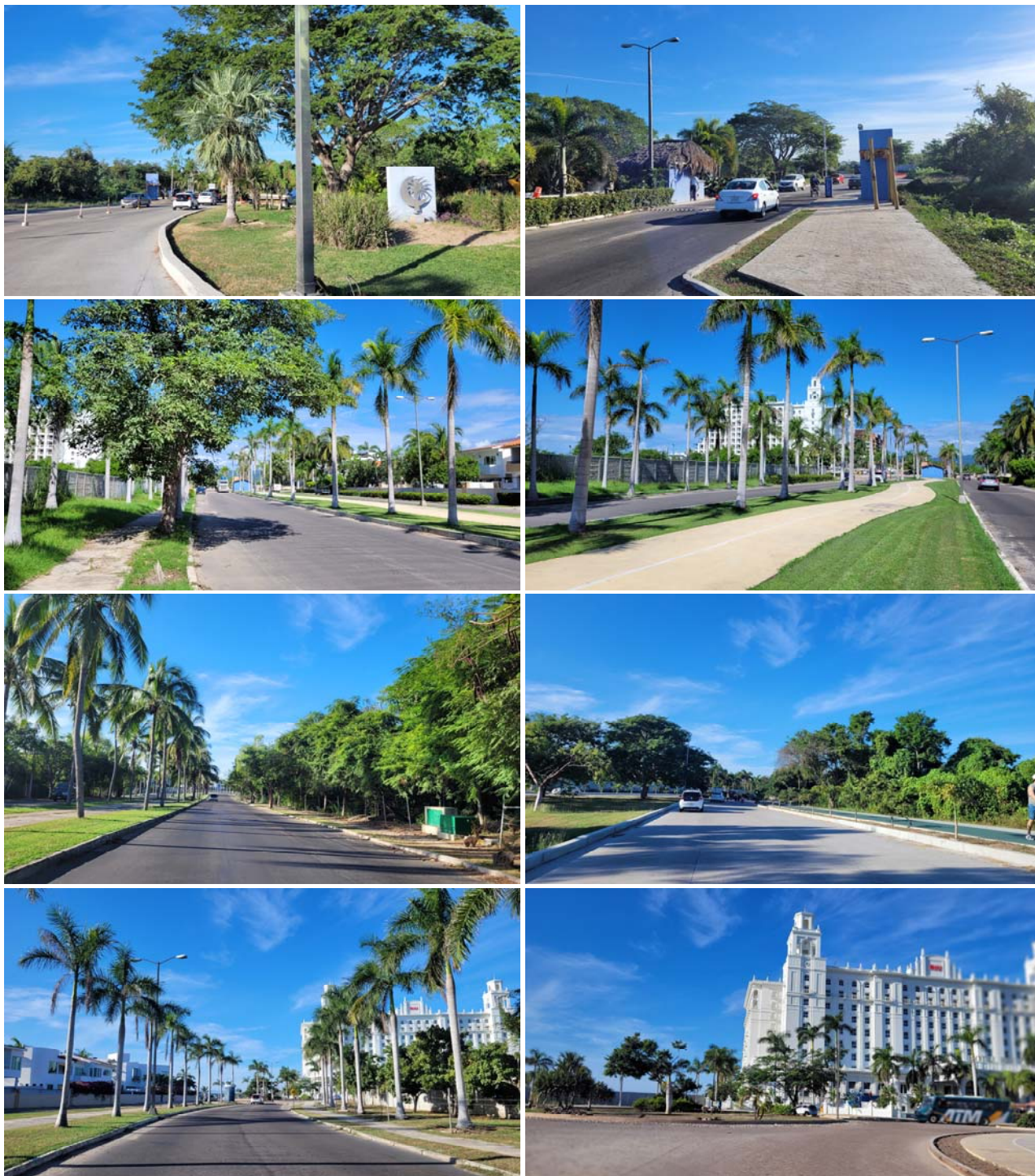
Figura II-12. Imágenes de infraestructura del Condominio Maestro Los Flamingos.
