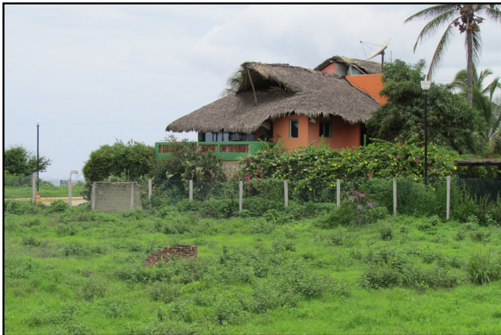
Fotografía 4. Colindancia Este del sitio del proyecto, con propiedad particular.
