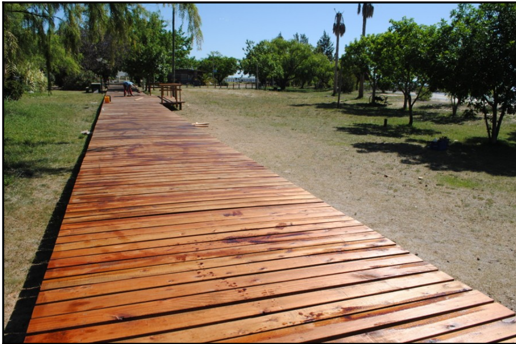
Fotografía 12. Bosquejo de la construcción de los Deck.
