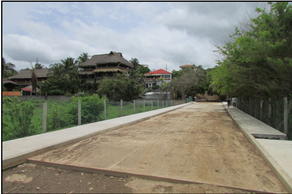
Fotografía 2. Colindancia Sur del polígono del proyecto con la calle Azucenas, nótese que la zona ya se encuentra urbanizada y con los servicios básicos.
